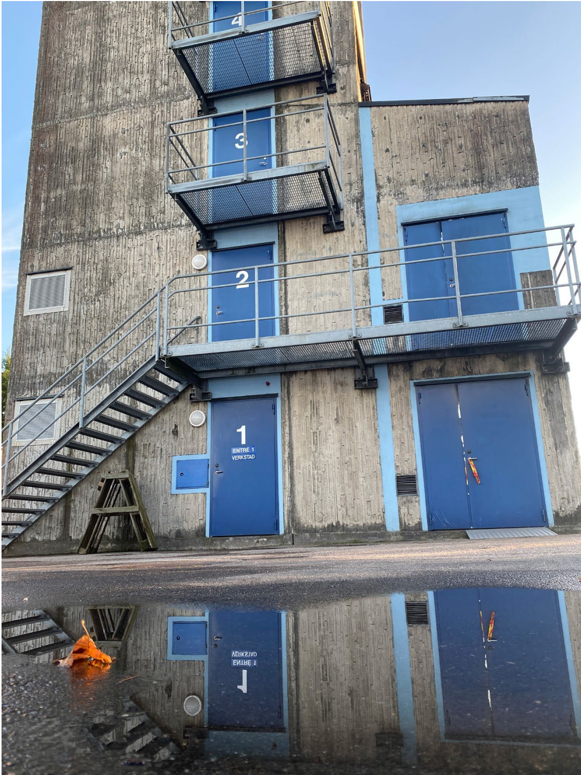
Övningshuset för bland annat varm rökdykning, Trollhättans brandstation.
